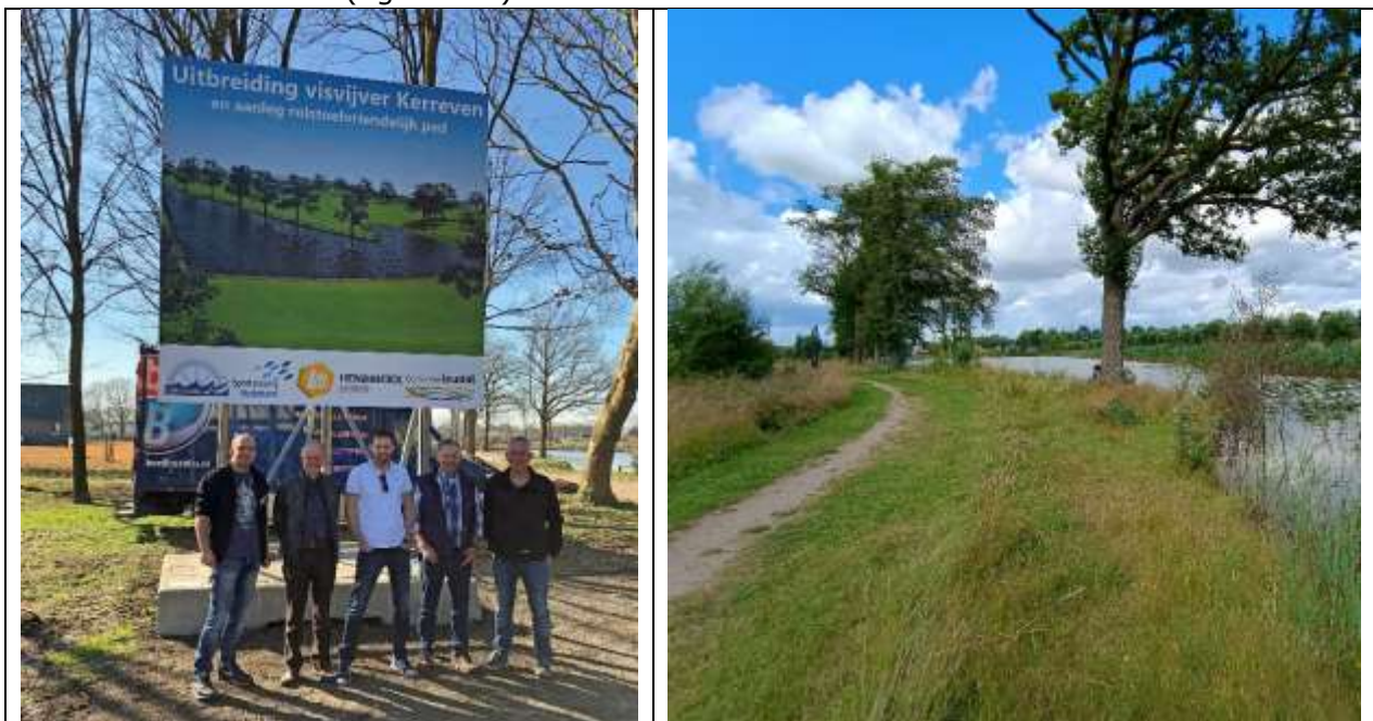
Figuur 2.2 Tijdens de renovatie en uitbreiding van de vijver in 2019 zijn vissteigers aangelegd, is de vijver uitgebreid en is een rolstoelvriendelijk pad aangelegd.
